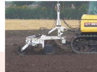
▲レーザーレベラー 均平作業
