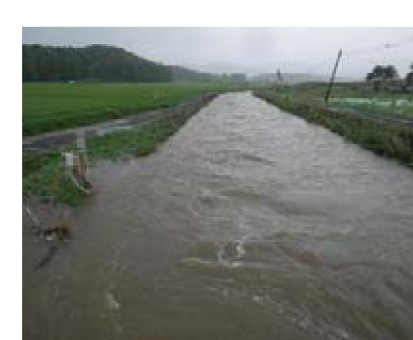
▲排水路の湛水
