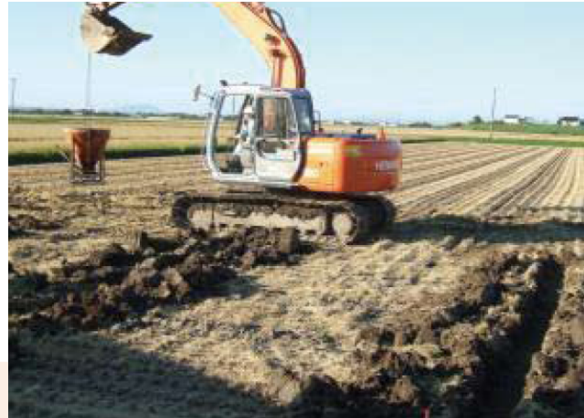
▲圃場枕地部分の排水改良
