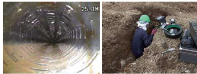
▲管内カメラによる撮影
